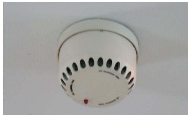
rilevatore automatico d'incendio
