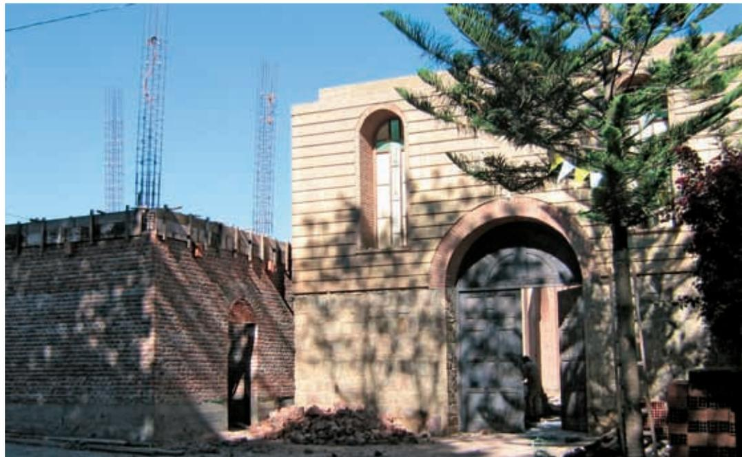
*servizi adeguati. Il progetto prevede lavori di manutenzione e ristrutturazione, in particolare il rifacimento di parte del tetto, costruzione dei servizi e di muri di mattoni, dato che gli attuali sono in "adobe", paglia e fango, e la sostituzione di alcuni serramenti. È previsto, inoltre, l'acquisto di attrezzature funzionali alla cucina, alla biblioteca e ai dormitori.*
