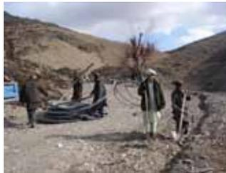
km di tubazioni, con relativo scavo del canale, la costruzione di 3 pozzezzetti di raccordo e la riqualificazione del raccordo principale dell'acquedotto.
